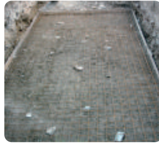
Ferrailage de la ceinture périphérique et de la dalle de fond.
