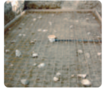
Mise en place de la bonde de fond et son tuyau sous le gros œuvre jusqu'au local technique.
