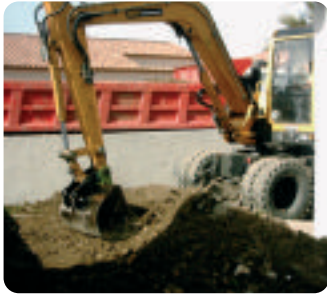
Accès au chantier : pelle mécanique et camion d'évacuation des terres.
