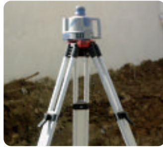
Vérification des niveaux à la lunette et terrassement de la fouille.
