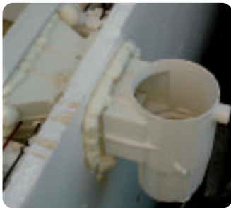
Callage des pièces à sceller à la mousse polyuréthane pendant l'élévation des parois.
