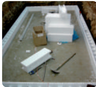
Montage du premier rang de blocs polystyrène.
