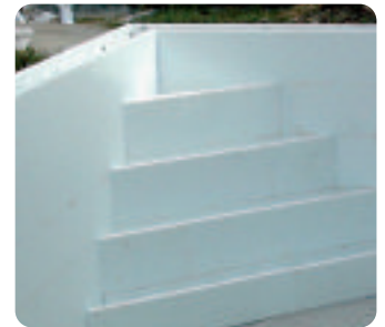
Montage des blocs de chaque marche de l'escalier d'angle.
