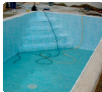
Placage sous vide du liner avec un puissant aspirateur. Etanchéité des pièces à sceller et découpe du liner lors du remplissage.
