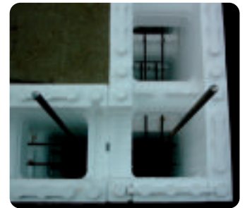
Détail d'un angle avec les fers tors horizontaux et verticaux.
