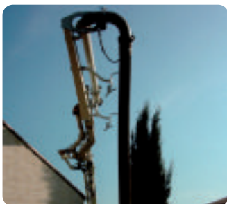
Le béton coulé dans les alvéoles forme des cheminées homogènes.
