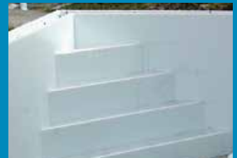
Montage des blocs de chaque marche de l'escalier d'angle.
