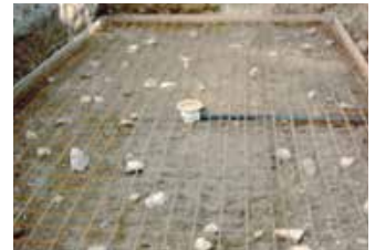
Mise en place de la bonde de fond et son tuyau sous le gros oeuvre jusqu'au local technique.
