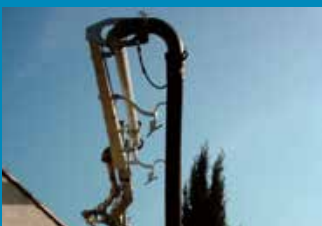
Le béton coulé dans les alvéoles forme des cheminées homogènes.
