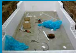
Élévation des parois avec positionnement des fers tors horizontaux.
