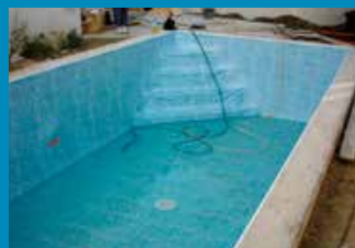
Placage sous vide du liner avec un puissant aspirateur. Etanchéité des pièces à sceller et découpe du liner lors du remplissage.
