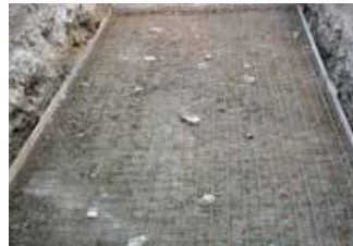
Ferrailage de la ceinture périphérique et de la dalle de fond.
