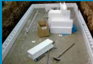
Montage du premier rang de blocs polystyrène.
