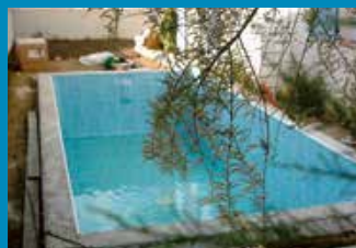
Après collage du feutre sur le fond et les parois, le liner est fixé sur le profilé à l'aide du « hung » d'accrochage.
