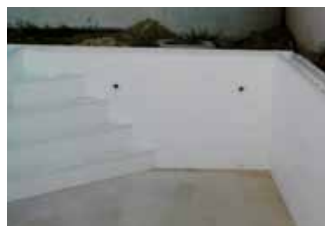
Les buses de refoulement et le projecteur sont fixés à la mousse polyuréthane avant le coulage du béton.
