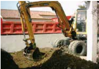
Accès au chantier : pelle mécanique et camion d'évacuation des terres.
