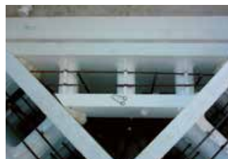
Détail du ferrailage des blocs de la paroi et de l'escalier.
