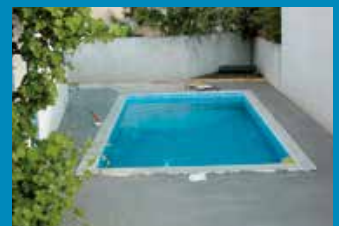
Mise en eau définitive après que le dispositif de sécurité soit opérationnel.
