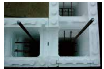
Détail d'un angle avec les fers tors horizontaux et verticaux.
